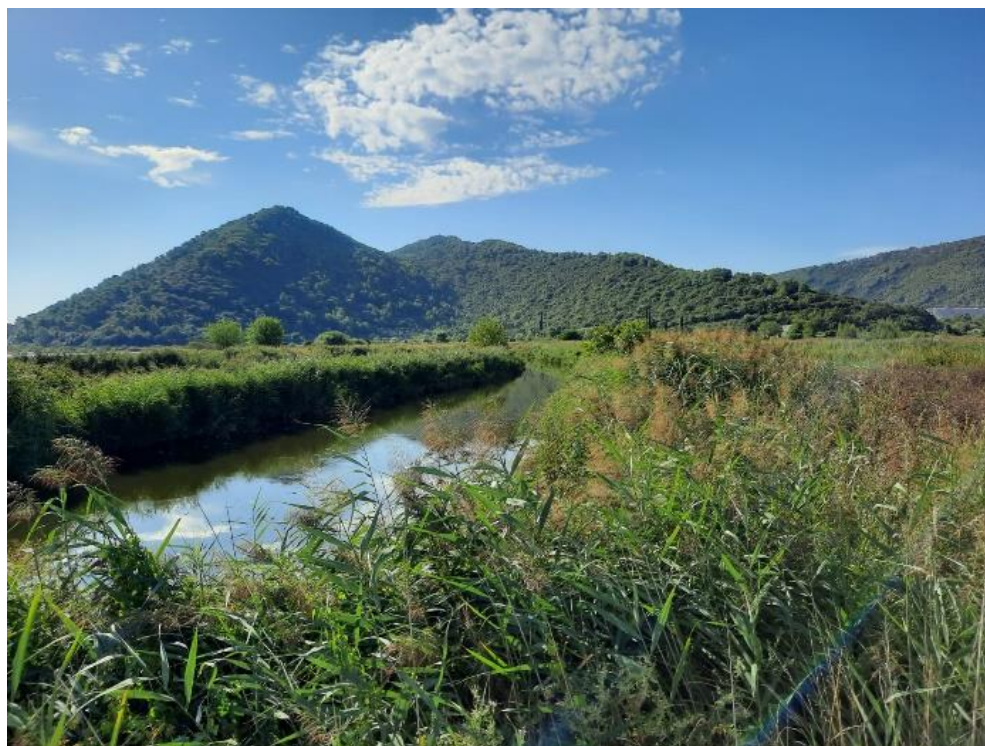
Slika 3.7.4.2. Prikaz odvodnih kanala u Stonskom polju
