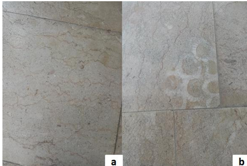
Slika 3.1.2.2 Popločenje Vidikovca: a) stilolitski šavovi; b) fosili rudista.
