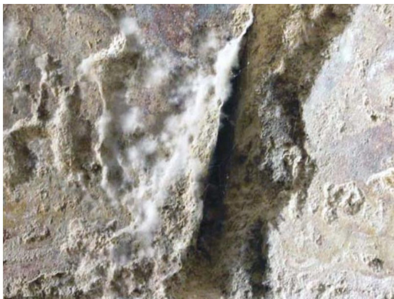
Slika 2.2.26. Biološka kolonizacija – plijesan na površini stijene Izvor: Vergès-Belmin, 2008.
