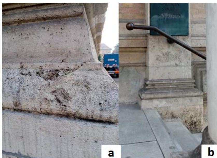
Slika 3.2.6.2. Palača Akademije. Prirodna struktura stijene otkrivena obradom, prljanje.
