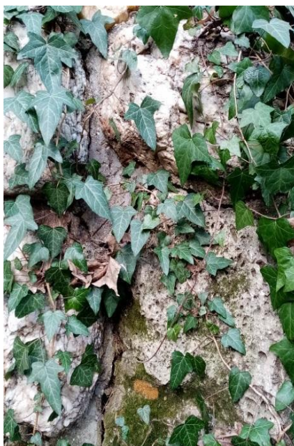
Slika 2.2.27. Biološka kolonizacija - vegetacijski obraštaj
