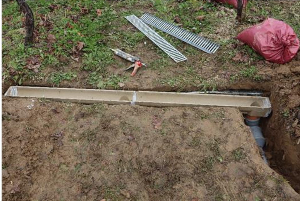
Slika 3.2.2. Postavljanje kanalice na određenom padu kako voda ne bi otjecala. Izvor: Defterdarović, J. (2020.)
