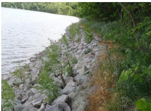
Slike 4.11 i 4.12: Ublažavanje erozije korita i obala postavljanjem vegetacijskog riprap -a (Izvori: https://www.mwcd.org/ , https://www.terraerosion.com/ – pristupljeno 15.2.2021.)
