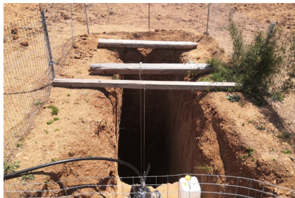
Slika 110. Otvorena jama za navodnjavanje, podzemna voda na dubini od cca 5 m
