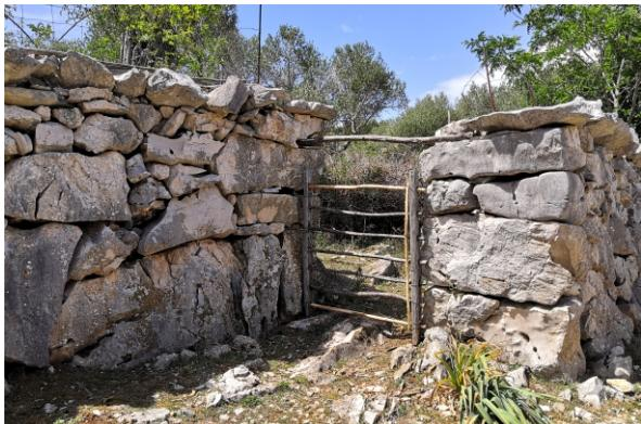
Slika 7. **Laz** – ulaz ili otvor na suhozidu prepriječen vratima; vrata su tradicionalno izrađena od dviju okomitih i nekoliko poprečnih grana
