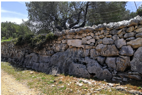
Slika 20. Kvalitetno zidani lunjski suhozid sa prepoznatljivom ozubom ojačan žičanom mrežom
