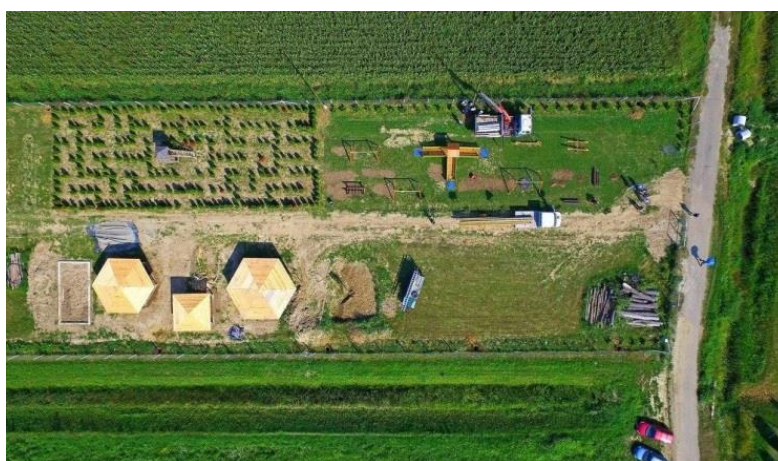
Slika 26. Snimka iz zraka na RES Antunovac tijekom izgradnje
