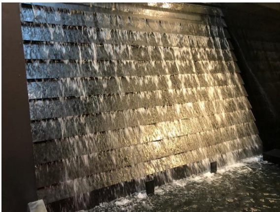
Slika 9. Vodeni zid, Arena centar, Zagreb, 2020.
