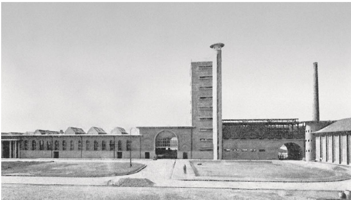
Slika 2 – Prodavaonica mesa, vodotoranj i strojarnica, izvorna fotografija s ulaza (Izvor: Prostor, Znanstveni časopis za arhitekturu i urbanizam, 23 (2015) 2 (50) )
