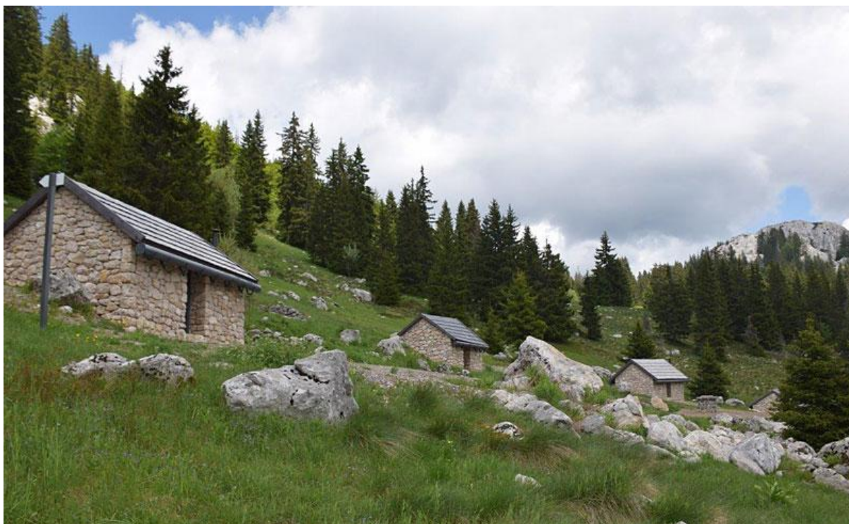
Slika 3.3.1. Obnovljeni pastirski stanovi na Lubenovcu
