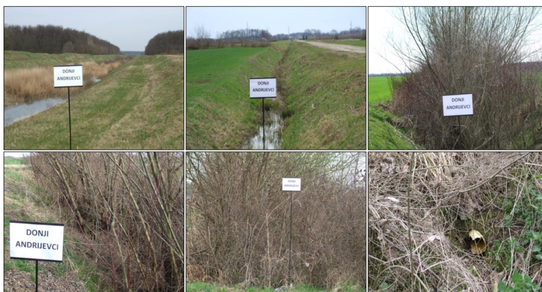
Slika 5.2.1.1. Fotografski prikaz stanja i obraslosti melioracijskih kanala na sustavnoj drenažnoj cjelini "Donji Andrijevc", travanj 2015. godine
