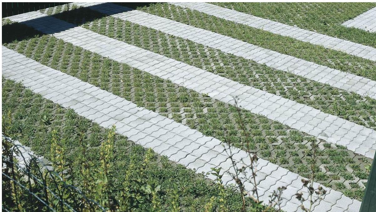
Slika 6. Prikaz betonske travnate rešetke
