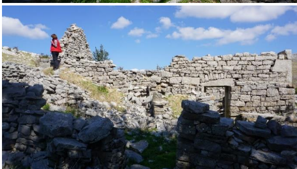
Slika 281., 282., 283., 284., 285., 286. Košara Mirka Maljkovića – na prve četiri slike se vidi prizemlje s ulazom košare građene od klesanog kamena. Na petoj slici je vidljivo kako je kuća građena na nagibu i usječena u brdo te se na šestoj vidi ulaz na gornji kat gdje su ulazile ovce iz pritorka
