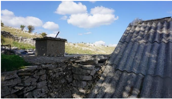
Slika 355. i 356. Bunar građen kamenom i betonom
