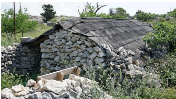
Slika 197. i 198. Moguće nekadašnja nastamba za čobana danas u funkciji štale prekrivene eternitom na koju se nastavlja tor za ovce u mjestu Smokvica
