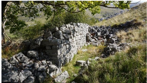
Slika 290. Ostaci košare usječene u brdo s jednim djelomično očuvanim zidom
