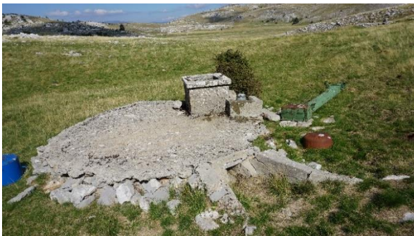
Slika 361. i 362. Gusterna za skupljanje oborinske/slivne vode izgrađena uz brdašce s kojeg se slijeva voda
