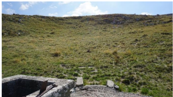
Slika 361. i 362. Gusterna za skupljanje oborinske/slivne vode izgrađena uz brdašce s kojeg se slijeva voda
