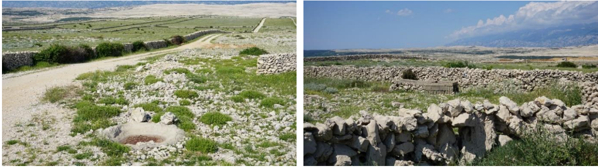
Slika 219. i 220. Betonska kamenica i suhozidno betonska cisterna za vodu na kolanjskim pašnjacima
