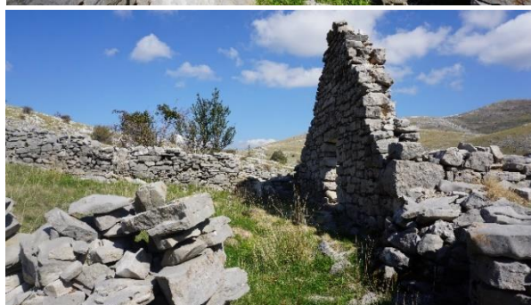
Slika 281., 282., 283., 284., 285., 286. Košara Mirka Maljkovića – na prve četiri slike se vidi prizemlje s ulazom košare građene od klesanog kamena. Na petoj slici je vidljivo kako je kuća građena na nagibu i usječena u brdo te se na šestoj vidi ulaz na gornji kat gdje su ulazile ovce iz pritorka
