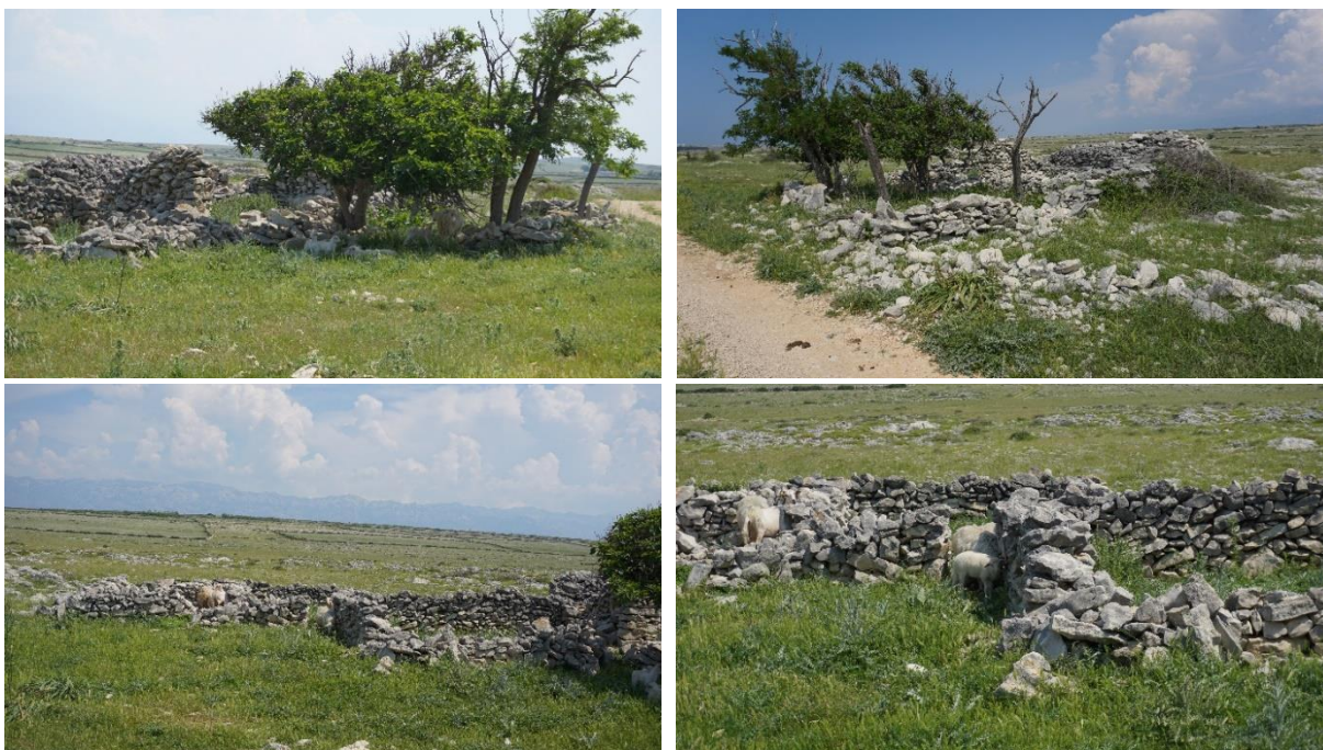
Slika 139., 140., 141., 142. Vjerojatno sklop stočarske nastambe i struge u ruševnom stanju na općinskom pašnjaku uz cestu u K.O. Povljana
