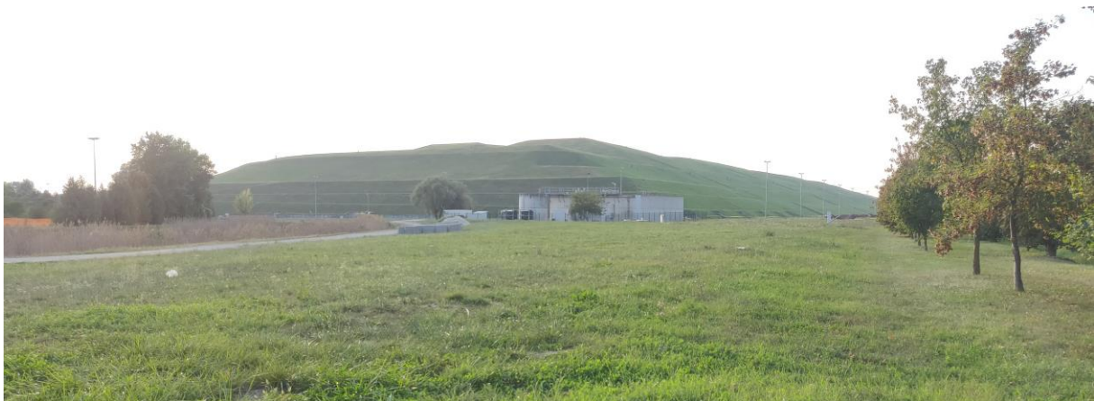
Slika 86: Pogled s točke G na Jakuševec
